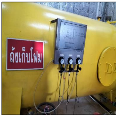
รูปที่ 2-33 อุปกรณ์แจ้งเตือน และอุปกรณ์ดับเพลิง บริเวณท่าเทียบเรือกลางทะเล (3)
