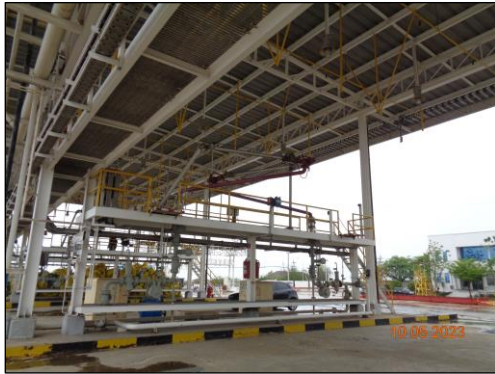
รูปที่ 2-7 Subsurface Loading Arms (1)
