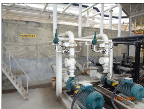
รูปที่ 2-5 สถานีปั๊มสูบ-จ่ายของคลังน้ำมัน (Pump PAD No.1) (3)
