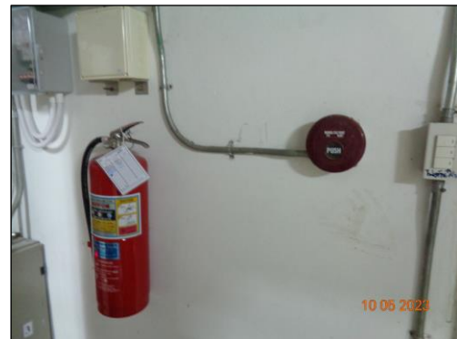
รูปที่ 2-46 อุปกรณ์แจ้งเตือน และอุปกรณ์ดับเพลิง บริเวณสถานีไฟฟ้าย่อย 2 (2)
