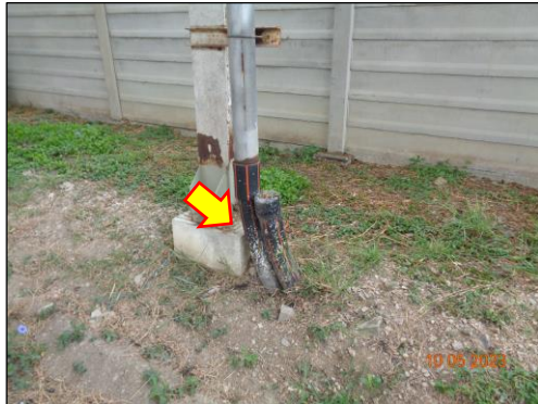
รูปที่ 2-61 ระบบสายดินบริเวณสถานีไฟฟ้าย่อย (Grounding System)
