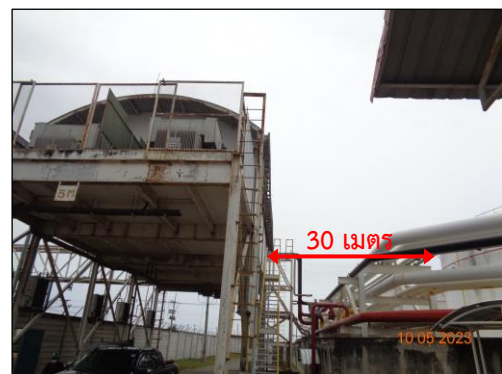
รูปที่ 2-36 สถานีไฟฟ้าย่อย และระยะห่างจากถังเก็บน้ำมัน
