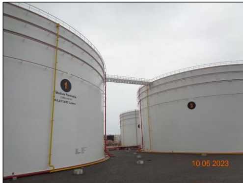
รูปที่ 2-1 ถัง Floating roofs
